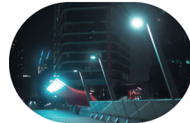
LED燈接線 安全防漏電
